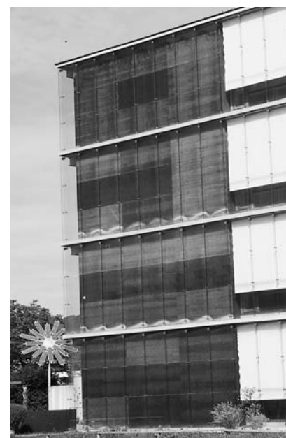
Schulhaus Mäder: Öffentliches Gebäude als Passivhaus
